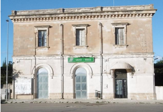
Stazione ferroviaria SALICE-VEGLIE
