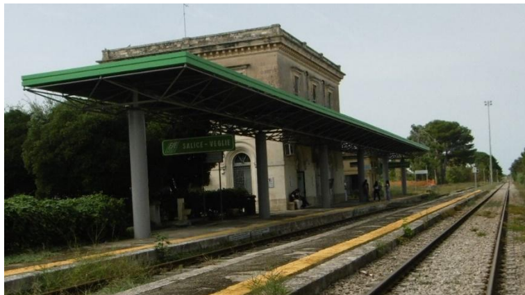
Stazione ferroviaria Salice-Veglie
